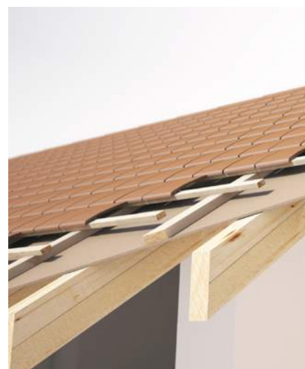
Dach vor der Renovierung (ohne Dämmung)
